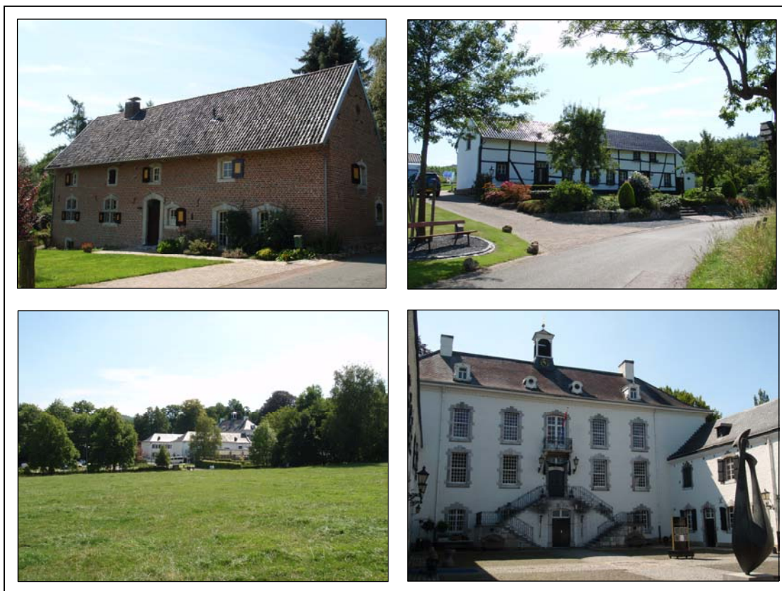
Figuur 4.16 De historische kern Raren. De foto's links en rechts boven tonen huizen zoals deze momenteel in Raren aanwezig zijn. De foto linksonder toont het kasteel Vaalsbroek, gefotografeerd vanuit het noorden. Rechtsonder toont het hoofdgebouw en de twee zijvleugels van het kasteel.
