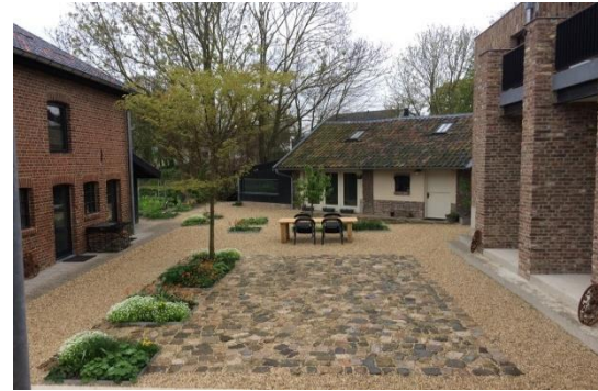
Binnenplaats met veldschuur(l.) en leemschuur (midden)
